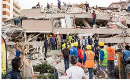
2020 depremi sırasında yıkılan binalardan birinin görünümü
