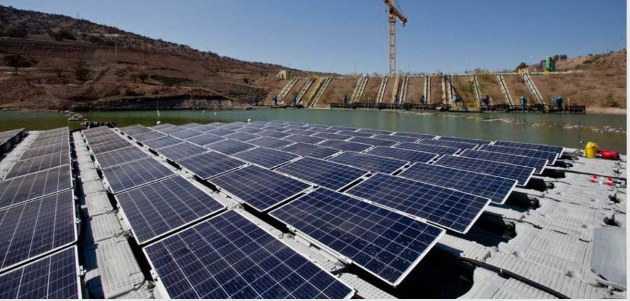
Görsel 4. Şili'nin Santiago kentine yaklaşık 65 kilometre (yaklaşık 40 mil) uzaklıktaki Los Bronces maden tesisindeki bir gölette güneş panellerinden oluşan bir ada yüzüyor; AP Fotoğrafı, Esteban Felix, Associated Press 4
